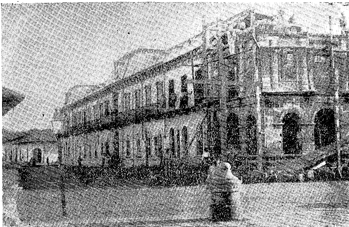
Frente norte del Palacio Nacional en construcción durante la ADMINISTRACION CHAMORRO
