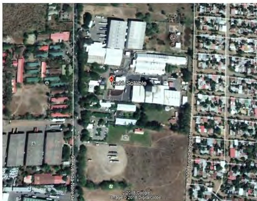
Vista aérea de la planta del Café Soluble S.A. en Managua
