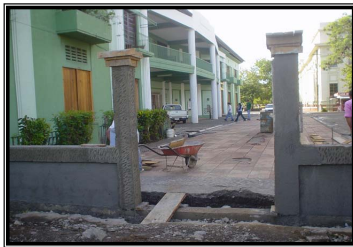
CONSTRUCCION DE MURO PERIMETARAL P.N.C. CCM.
