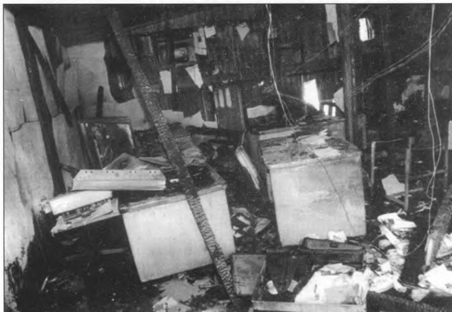
Estado en que quedaron estas oficinas después del incendio del martes 25 de julio de 1989.
