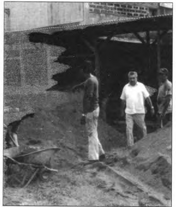
El Ing. Xavier Chamorro dirigiendo trabajos de construcción.
