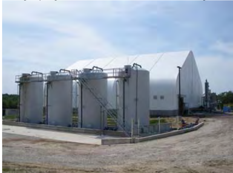
En primer plano los tanques con la solución de sales orgánicas, al fondo el biodigestor cubierto de 38 m x 38 m x 15 m de alto. Terrabon LLC, Bryan TX
