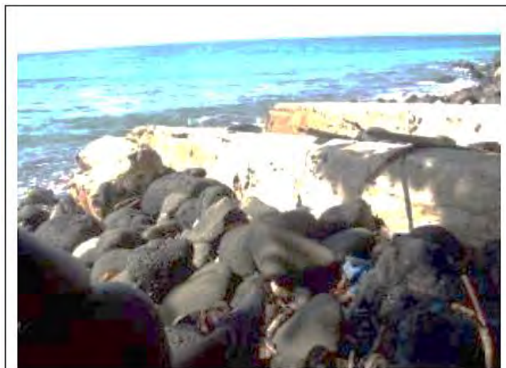
Fig. N° 18. Gradas del antiguo astillero aparentemente construido alrededor de 1970
