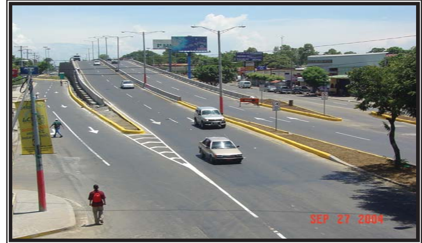
Intersección Portezuelo: Vista oeste Puente a Desnivel.
