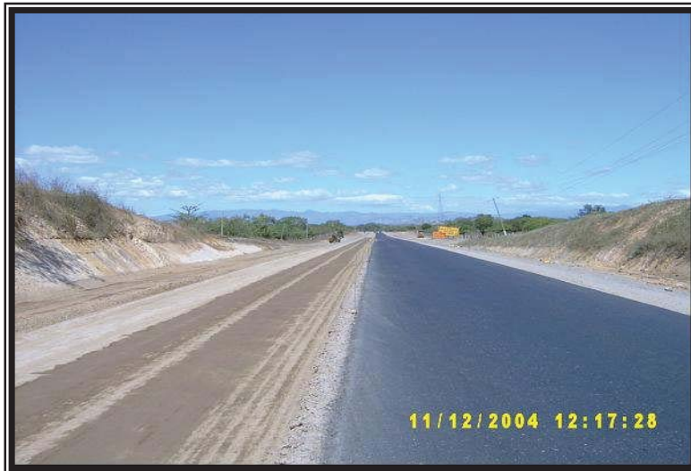
Colocación de base negra, banda derecha (Est. 184+400)
