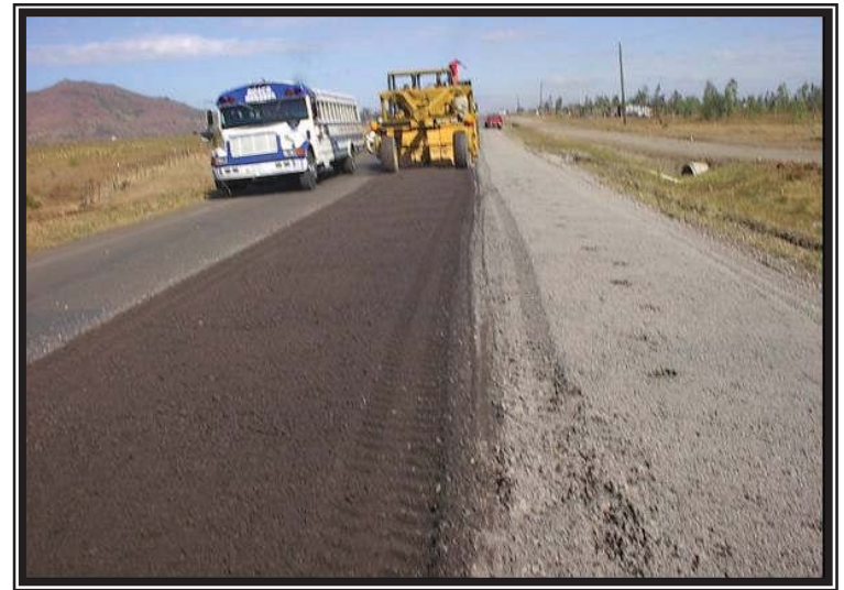
Trabajos de reciclado , banda derecha Est. 5+770
