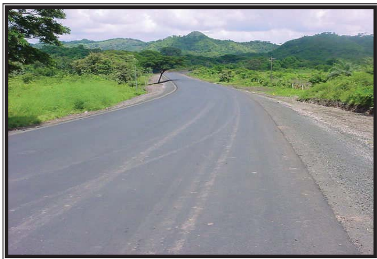
Carpeta De Rodamiento Terminada En La Est. 30+200
