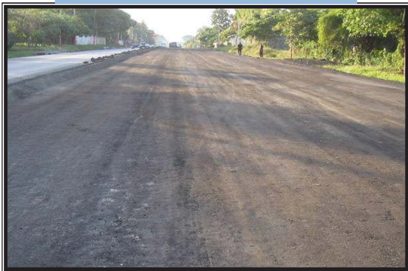
Sub base terminada, banda izquierda (Est. 6+000)
