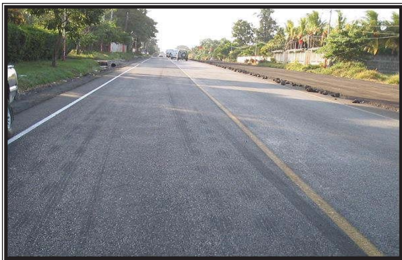
Colocación de carpeta asfáltica, banda derecha (Est. 6+200)
