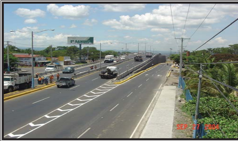
Intersección Portezuelo: Puente a Desnivel en funcionamiento.
