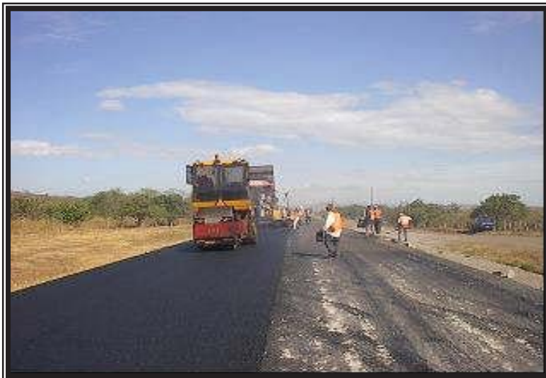
Colocación de carpeta asfáltica, banda izquierda Est. 5+770
