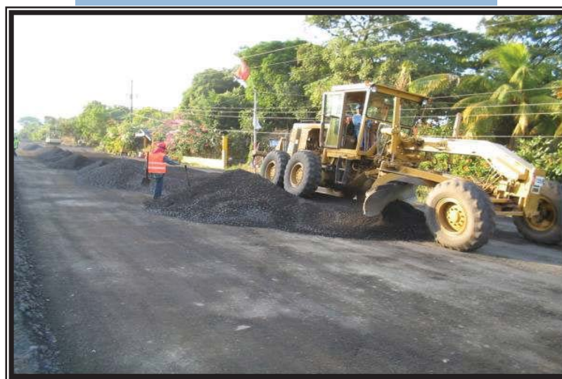
Colocación de material de base, banda izquierda (Est. 5+800)
