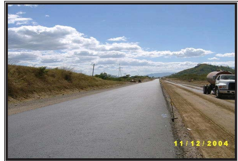
Preparación de terracería, banda derecha (Est. 189+660)
