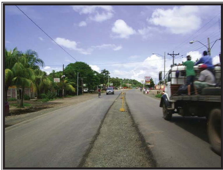
Carpeta Asfaltica Con Area Para Boulevard Est. 24+200
