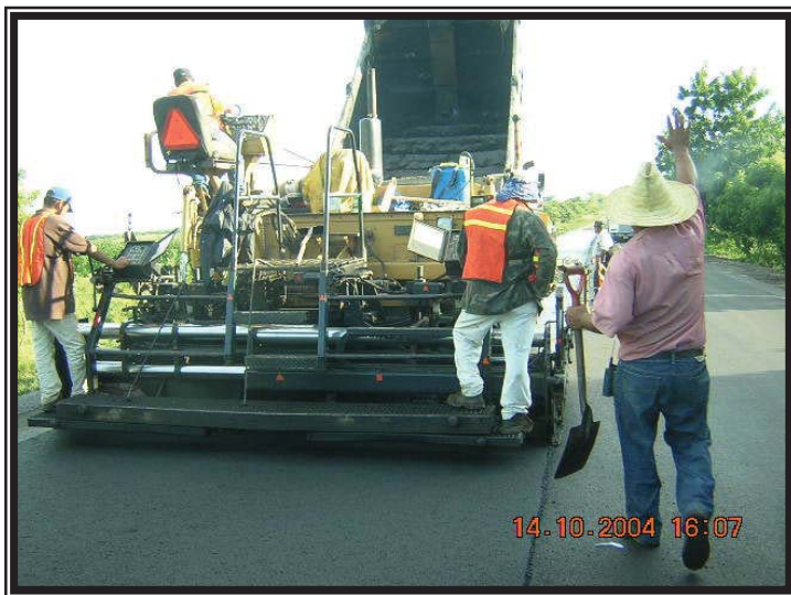
colocación de segunda capa de mezcla asfáltica bituminosa en Estación 6+500
