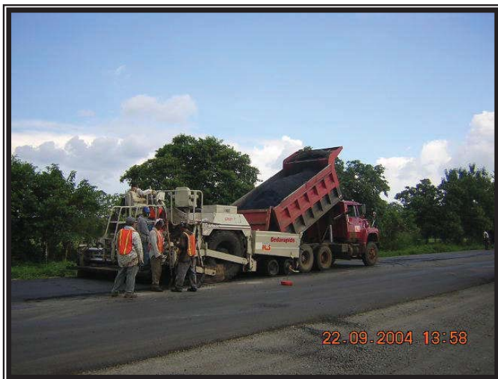
capa de Concreto Asfáltico Bituminoso Estación de la 3+000 a la 19+200
