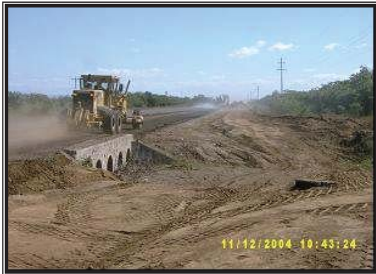
Proceso de terracería, banda derecha (Est. 162+500)
