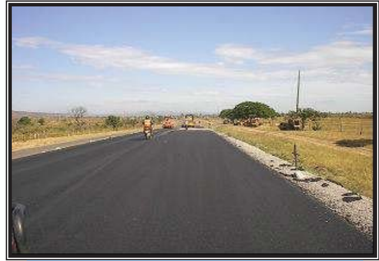
Carpeta asfáltica colocada Est. 0+700
