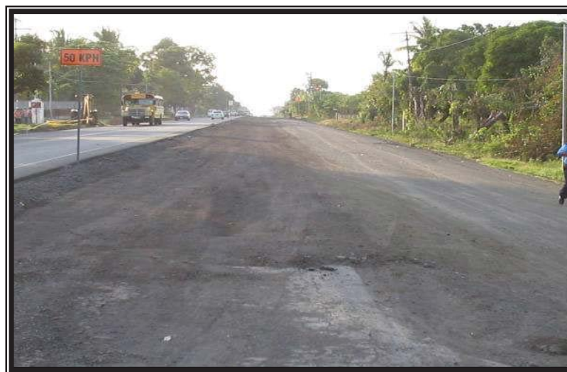
Colocación de sub base, banda izquierda (Est. 6+200)
