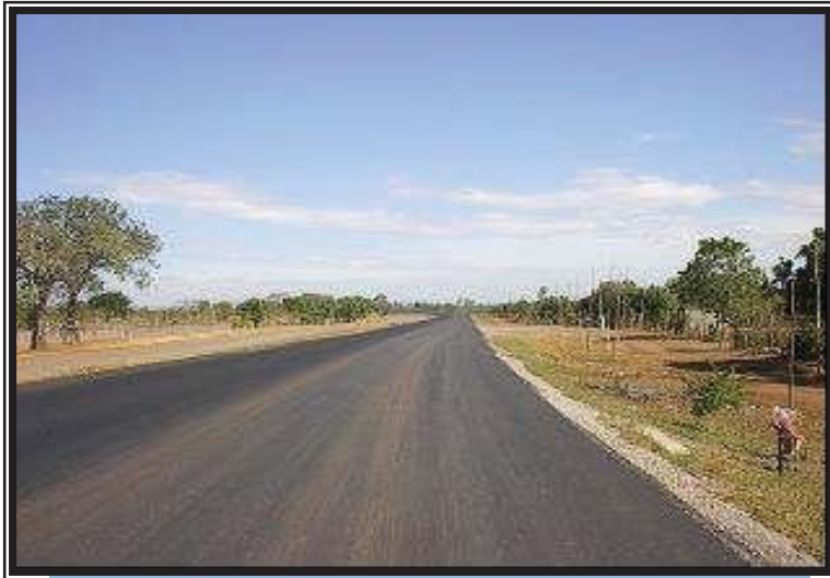
Carpeta asfáltica colocada Est. 0+400
