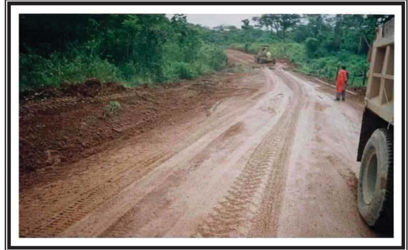
Equipo y Maquinaria de El Contratista SEMCO realizando labores de reparación de la superficie de rodamiento dañada por las lluvias en el sector Estación 511+500.
