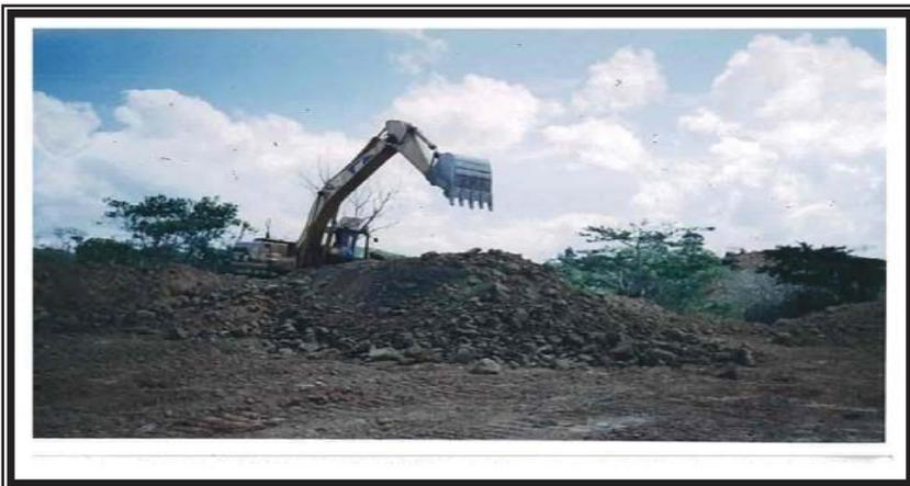
Excavadora de Oruga de El Contratista en proceso de extracción y acopio de material en el Banco de Préstamo “La Curva” en el sector de Okonwas Est. 451+438
