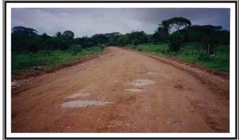
Daños leves producidos por las lluvias sobre el rodamiento en el sector del camino Estación 514+500
