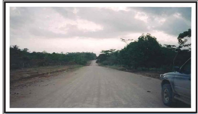
Sector del camino Est. 498+100 en la comunidad La Pistolera en donde se muestra la Superficie de Rodamiento con recubrimiento de material del Banco de Préstamo “El Cocal”, la cual ha soportado las fuertes lluvias y el alto flujo vehicular
