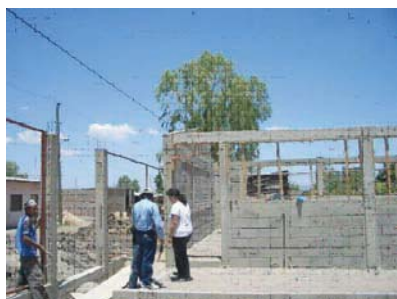
Construcción de Preescolar, Barrio Santo Domingo, Estelí
