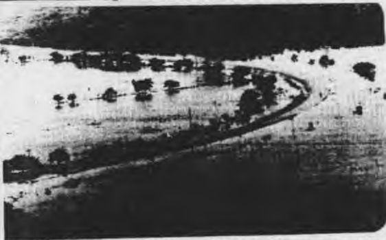
La foto de la derecha corresponde a un tramo de la carretera Chinandega-Somotillo. La cinta asfáltica exhibe nitidamente su curva con agua por ambos lados. (Foto: Carlos García B.)
