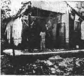
Las dos paredes de esta casa equinera se desplomaron en un instante, dejando al apesadumado y a la familia totalmente al descubierto. Ahora tienen un domicilio en el patio.
