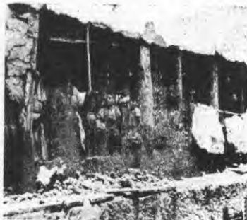
Cuando hicieron esta casa, no le pusieron ventanas, pero el terremoto le abrió una de 18 varas de largo y de buen alto, quedando una extrema familia viviendo en tal forma que todo mundo da cuenta de lo que están haciendo con sólo pasarse por la calle.
